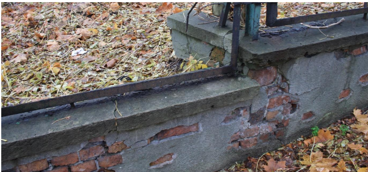
graf. 94 Istniejące ogrodzenie pełni jednocześnie rolę murka oporowego – źródło: zasoby własne
