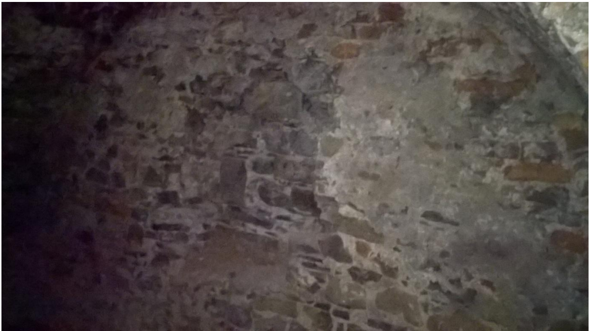
Fot. 14 – Wnętrze komory K2 – ściana szczytowa wschodnia.
