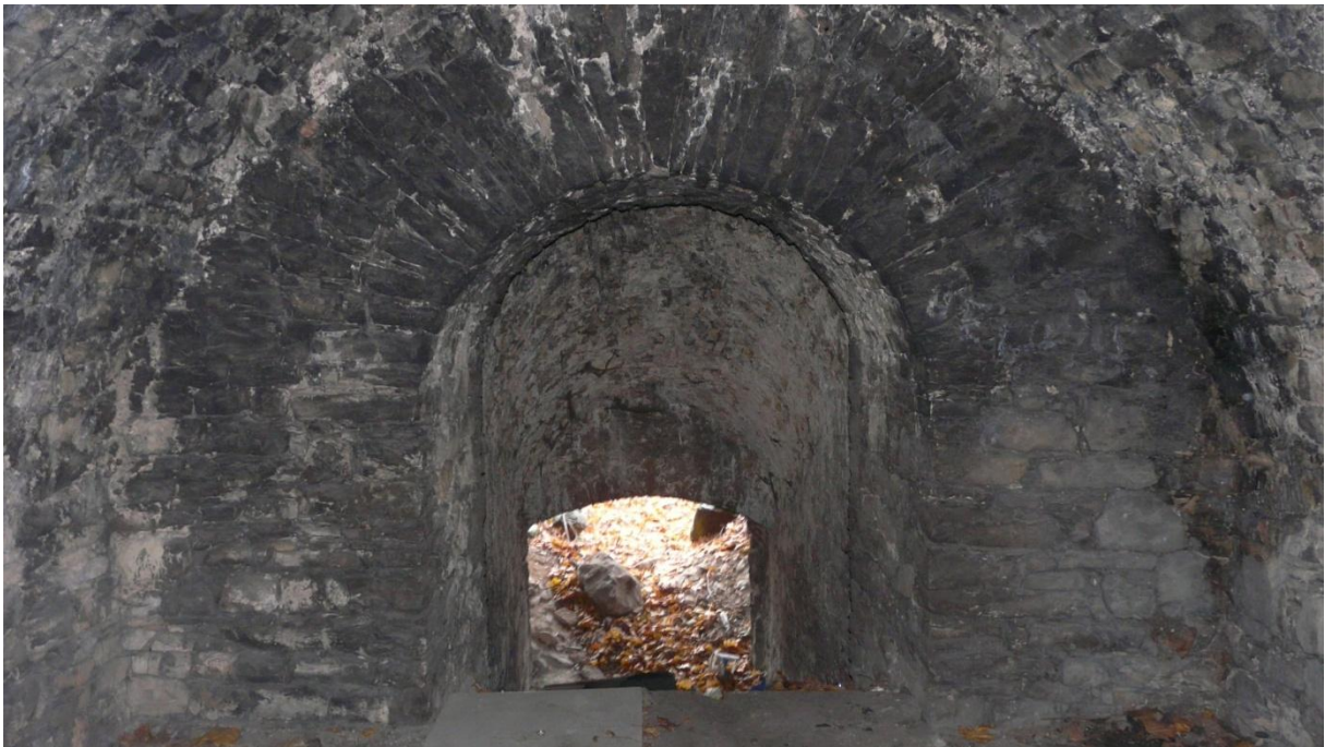
Fot. 2 – Widok na ścianę zachodnią komory K1 z korytarzem schodzącym do bramy zachodniej.
