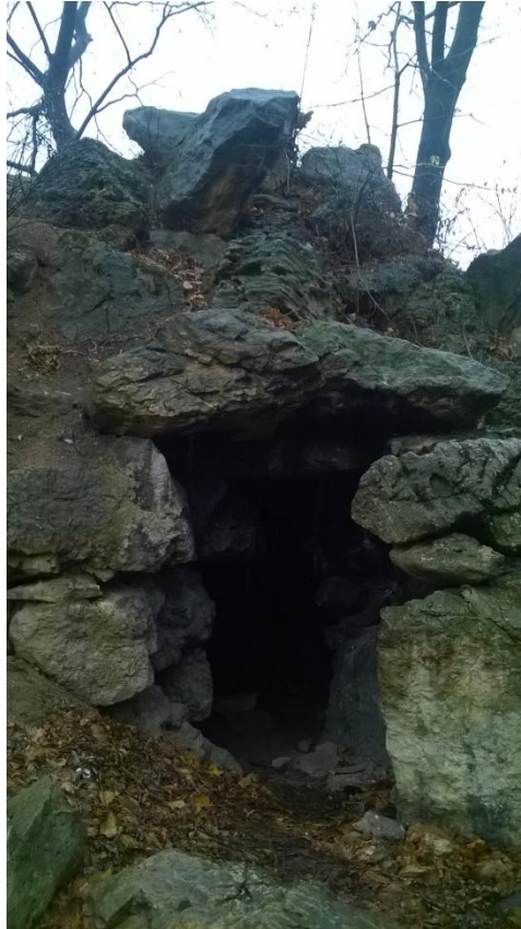
Fot. 5 – Brama południowa do K1 od strony zewnętrznej
