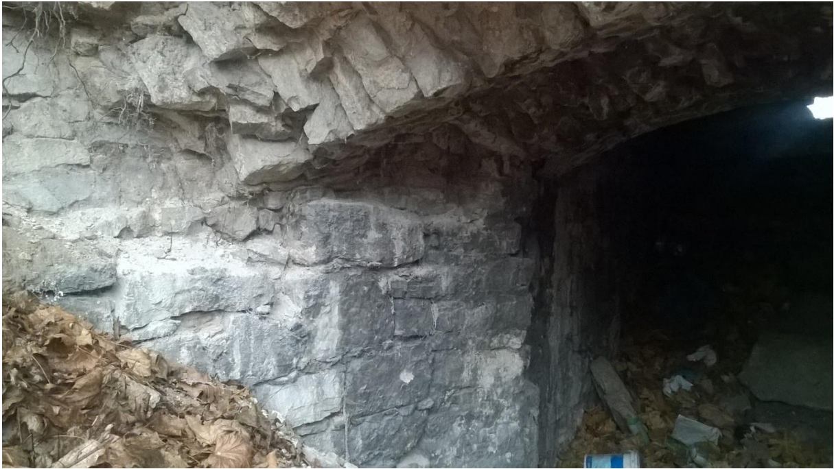
Fot. 9 – brama zachodnia do K1 – ubytki sklepienia przy oparciu północnym.
